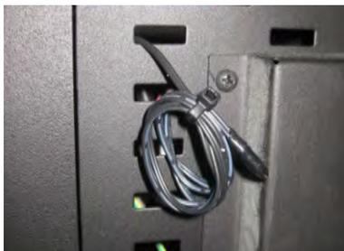
**Figura 20 - Sonda de temperatura ambiente**
