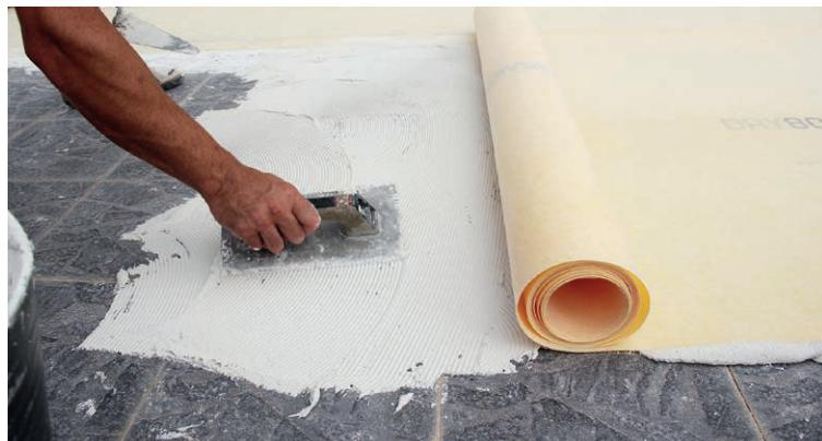
**1.** Comprobar la estabilidad del soporte y limpiar la superficie, a continuación aplicar cemento cola clase C2 con lana dentada. Aplicar el adhesivo en pequeños paños para evitar que se seque. En ningún caso instalar la lámina DRY80 sobre un cemento cola semi fraguado.
