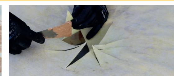
**3.** Poner lámina DRY80 encima y cortar como en la imagen. Aplicar adhesivo SEAL PLUS en la unión de la lámina con el interior del sumidero.
