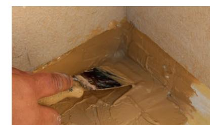
**1.** Una vez instalada la lámina DRY80 aplicar adhesivo SEAL PLUS sobre la zona.
