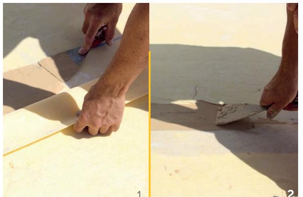
**4.** Realizar las uniones entre láminas con adhesivo SEAL PLUS. Poner una primera capa entre láminas (1) y rematar la junta por encima con SEAL PLUS (2) doble sellado.
