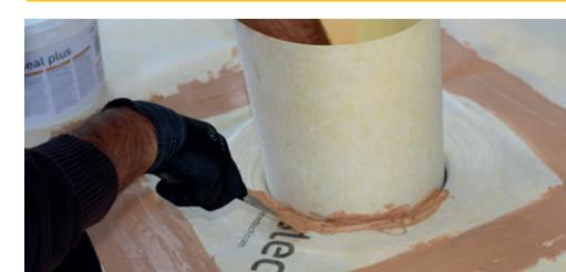
**1.** Introducir un corte de lámina DRY80 en forma de tubo dentro del sumidero y sellarlo con adhesivo SEAL PLUS.
