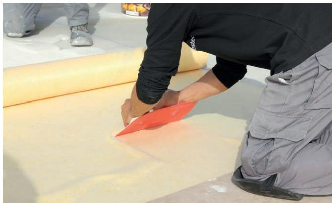
**2.** Presionar fuerte la lámina DRY80 sobre el soporte con ayuda de la llana, asegurándonos de eliminar con todas las posibles bolsas de aire que se hayan generado. **ATENCIÓN:** una vez instalada la lámina, debemos asegurarnos de que esté totalmente pegada al soporte.
