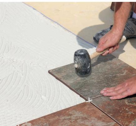
**5.** Colocar el pavimento directamente con cemento cola clase C2 y fijar el rodapié. Trabajo terminado de manera rápida, fácil e con garantía de calidad.
