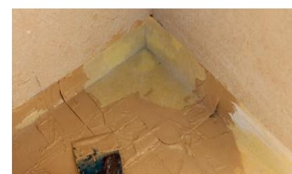
**2.** Colocar la pieza DRY80 CORNER-OUT o CORNER-IN y volvemos a aplicar adhesivo SEAL PLUS sobre la pieza.
